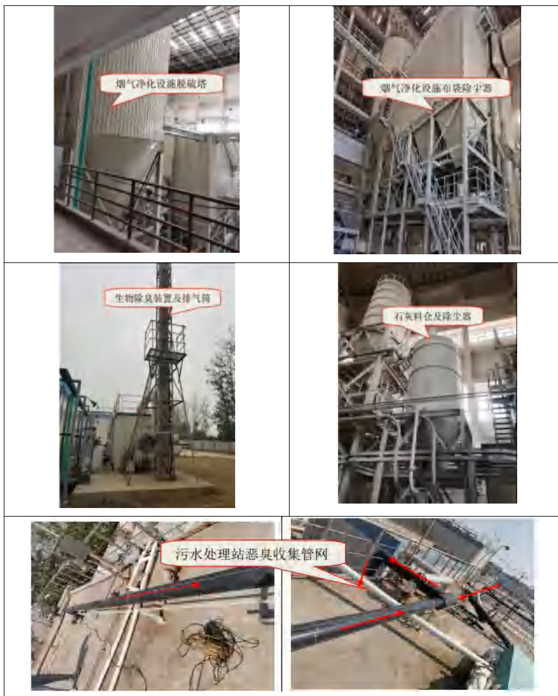
图 2.2-10 各废气处理设施图
