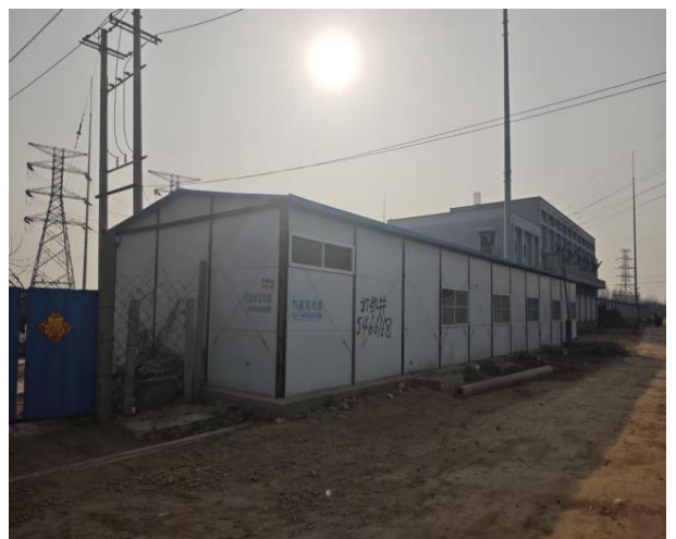
变电站东北侧围墙外 2m 简易板房
