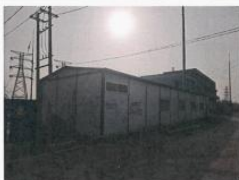
图 6 变电站东北侧围墙外 2m 简易板房
