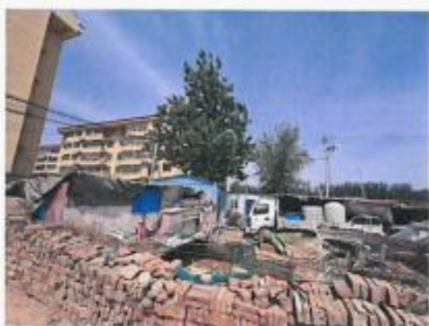
图4 地下输电缆线东2m 临街板房
