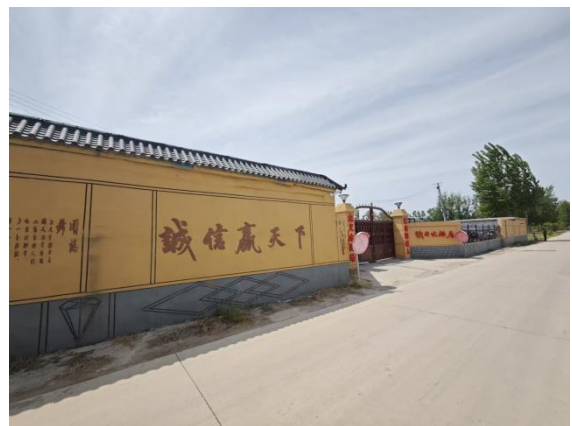
拟建站址东侧围墙外 12m 厂房
