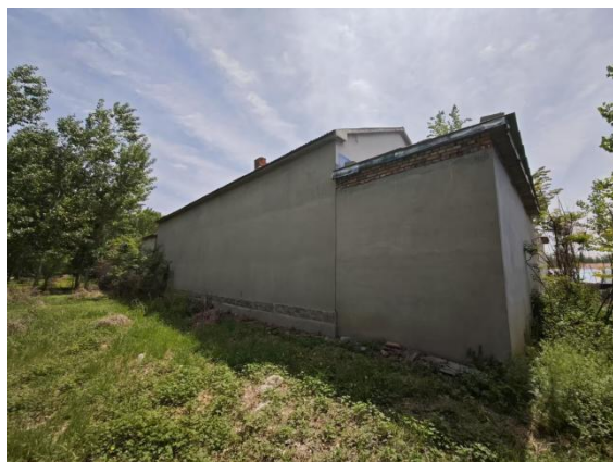
拟建架空线路东南 21m 民房
