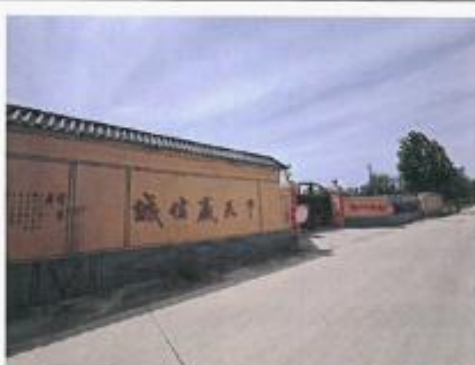
图7 拟建站址东侧围墙外12m 厂房
