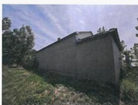
图11 拟建架空线路东南 21m 民房
